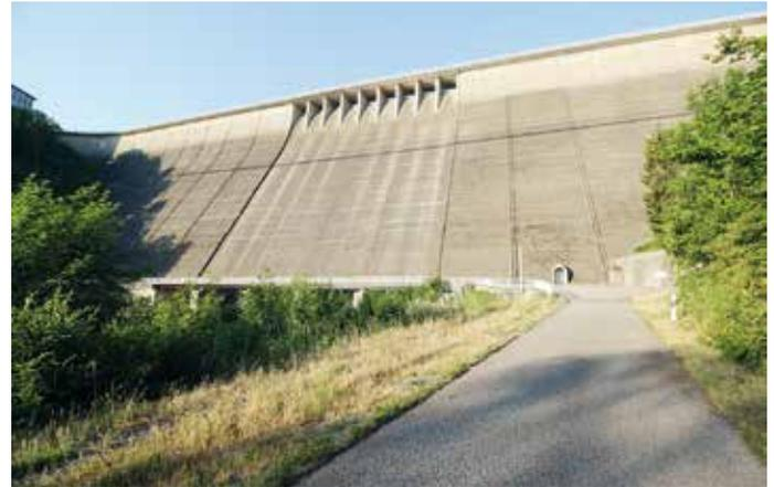
Bei der über der Gründungssohle 106 Meter hohen Rappbodetalsperre stemmen sich zwei Millionen Tonnen Beton gegen die Wassermassen. Foto: Sven Bardua, 2022
